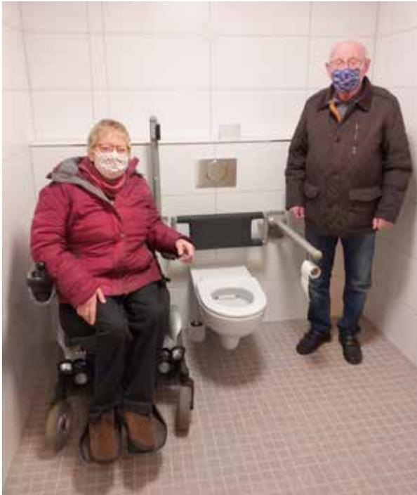
ist. Normgerecht wurde die barrierefreie WC-Anlage erstellt mit der nötigen freien Bewegungsfläche vor und neben dem WC, den klappbaren Stützgriffen und dem unterfahrbaren Waschbecken mit leicht bedienbarer Armatur.
